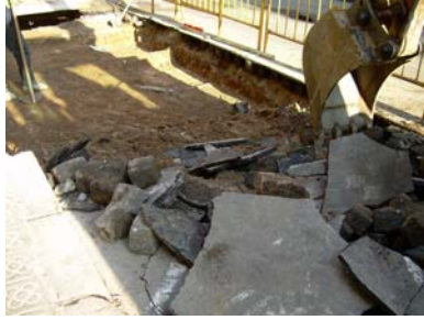
49. Treballs d'excavació per a la
