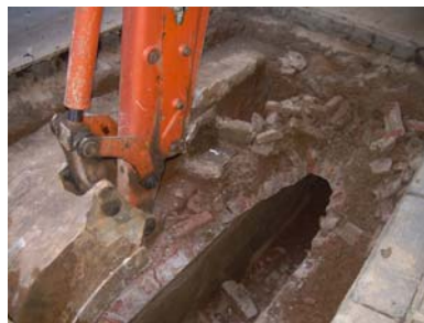
29. Treballs de desmuntatge al
