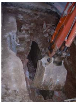
28. Treballs de desmuntatge al
