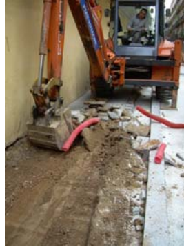
50. Treballs d'excavació per a la
