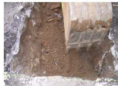
45. Treball d'excavació del dipòsit 4
