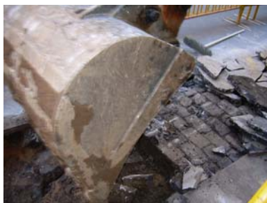
02. Treballs d'excavació de la rasa
