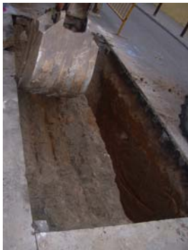
31. Treballs d'excavació del dipòsit
