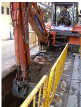
01. Treballs d'excavació de la rasa
