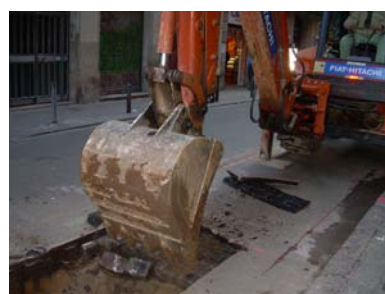
06. Treballs d'excavació del dipòsit
