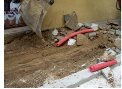
51. Treballs d'excavació per a la
