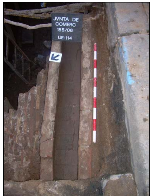
Vista del segon tram de la claveguera UE 114 , tallada per un altre claveguera ( UE 133 ).
