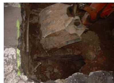
48. Treballs de desmuntatge al
